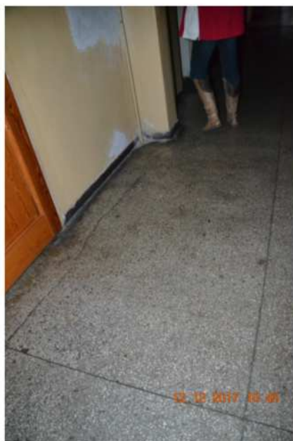
Fot.27 Posadzka lastrykowa - stan techniczny - ZADOWALAJACY.
