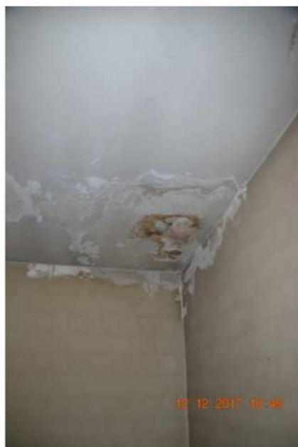
Fot.26 Główna klatka schodowa. Zbliżenie zacieku z dachu.
