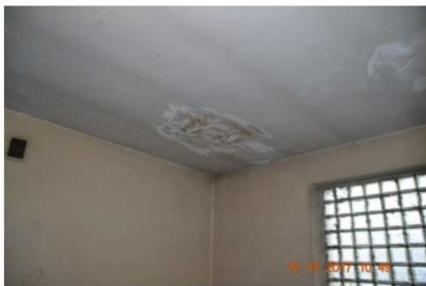
Fot.25 Strop nad główną klatką schodową - zaciek.
